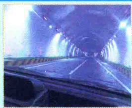
秦岭终南山隧道
