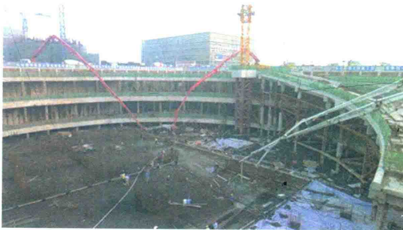
图9.10 大体积混凝土基础
