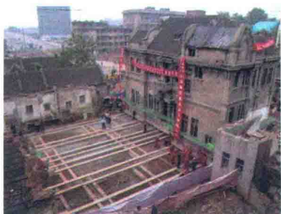
图10.11 古建筑横向平移
