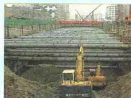
地基基坑围护钢支撑
