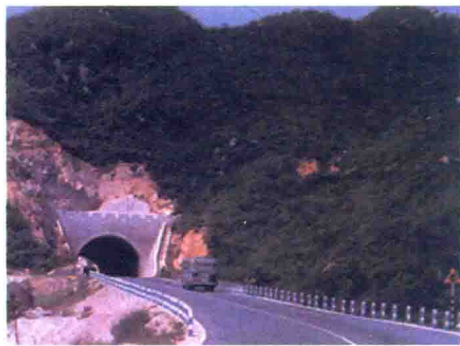
图5.22 北京八达岭公路隧道
