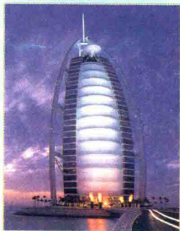
中东阿拉伯联合酋长国迪拜340 m高的标志性膜建筑物——阿拉伯塔酒店为典型的膜结构。
