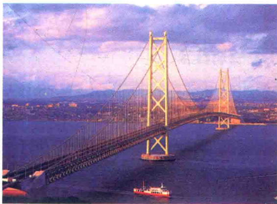
图6.16 日本明石海峡大桥
