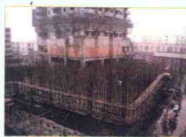
钢筋工程施工现场
