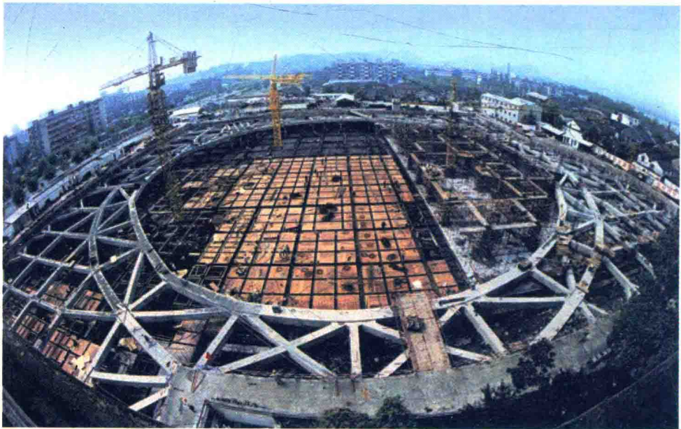
图3.2 正在施工中的地下工程
