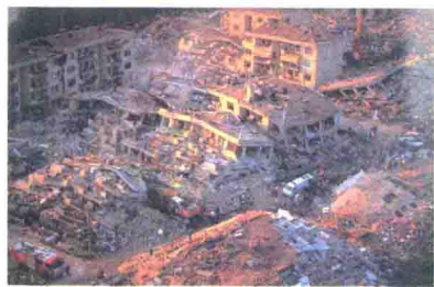
图10.1 地震造成的房屋倒塌
