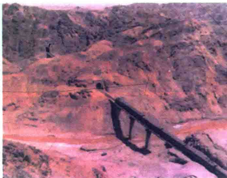
图5.21 青藏线锡铁山分水岭隧道
