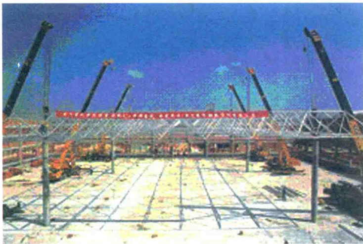
图9.27 网架施工（整体提升及整体顶升法）
