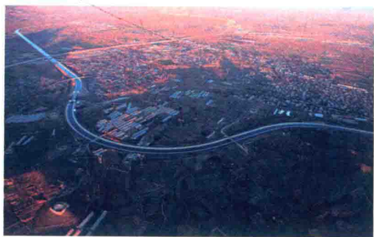
图8.10 南水北调中线工程
