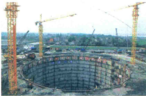
图9.6 深基坑施工
