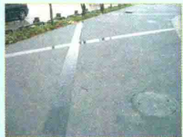
透水混凝土路面
