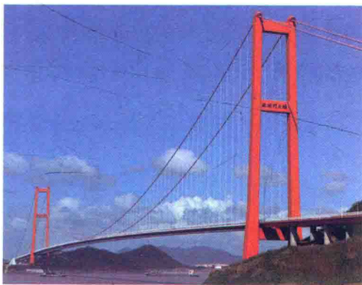
图6.17 舟山西堠门大桥
