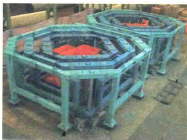
图 10.8 上海环球金融中心的风阻阻尼器
