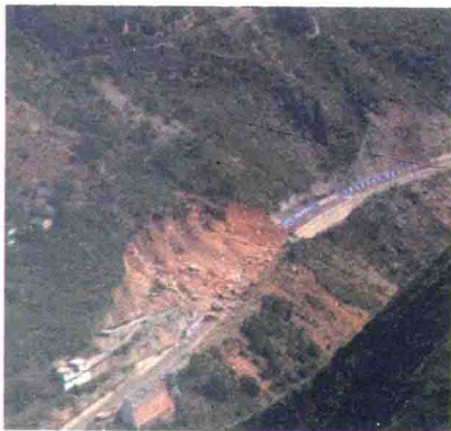
图10.9 山体滑坡堵塞道路
