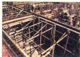
模板工程施工现场
