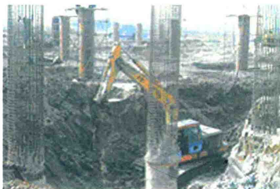
图9.7 桩基础施工
