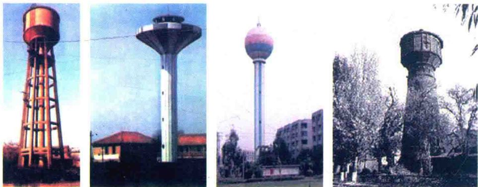
图4.27 圆柱壳式、倒锥壳式、球形、箱形水塔
