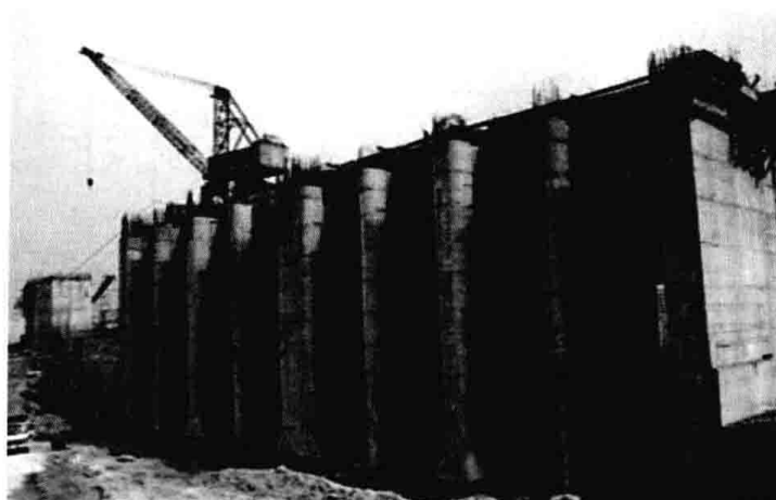
施工中的闸墩
