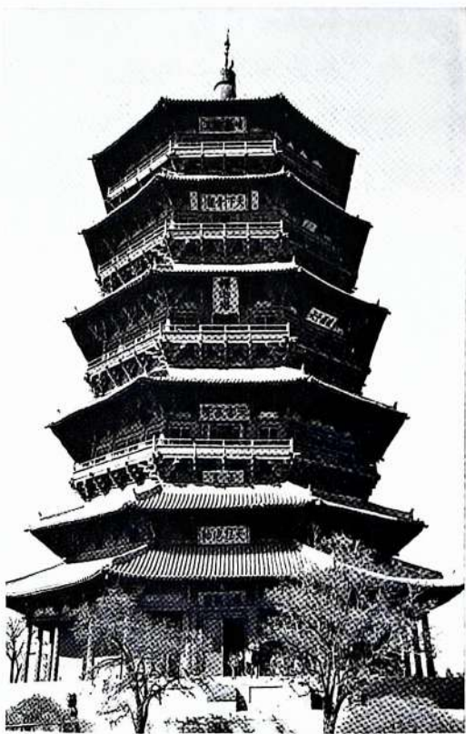
图 8-9 山西应县木塔
