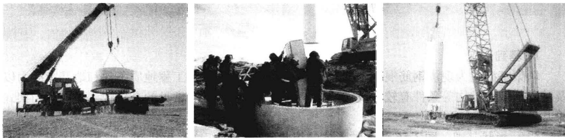
图 3-53 塔筒吊装
