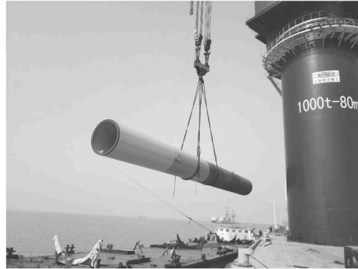
图5-4 岸上重型吊机进行基础装船
