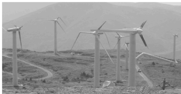
图3-11 风电机组叶片破坏 [32]
