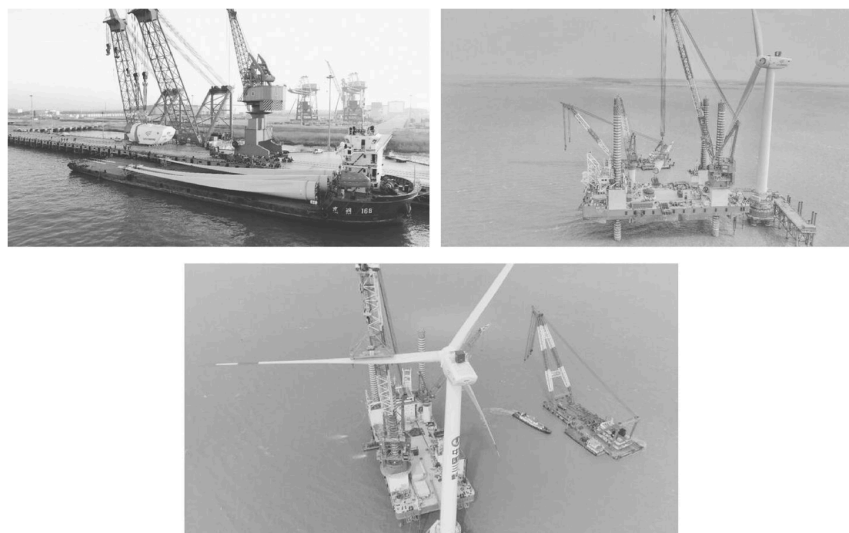
图5-25 第三种单叶式风电机组安装方式
