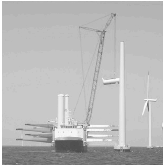
图5-31 Nysted海上风电场风电机组吊装
