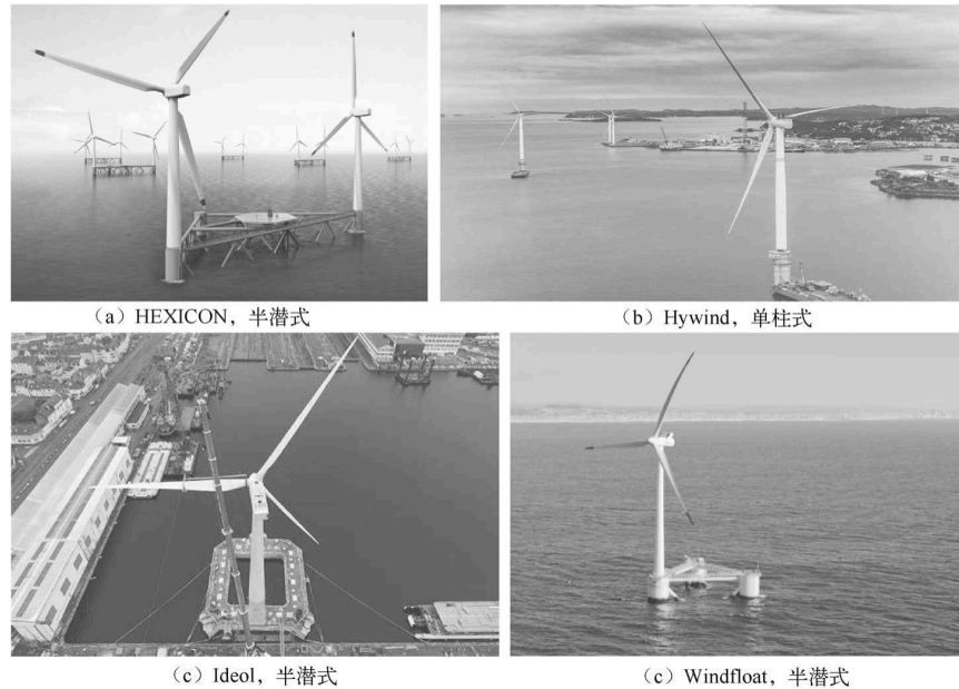
图5-22 浮式基础风电机组类型
