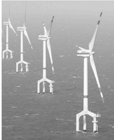
图5-13 三桩基础海上风电机组
