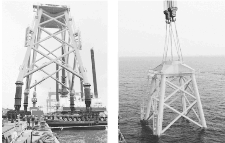
图5-17 中广核阳江江南鹏岛海上风电机组基础
