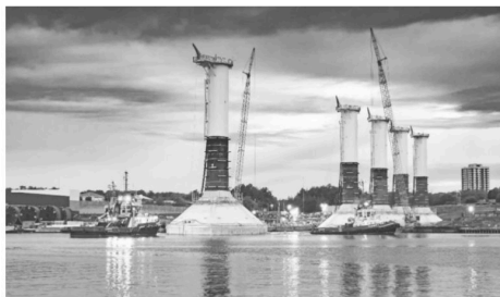
图5-20 重力式基础运输
