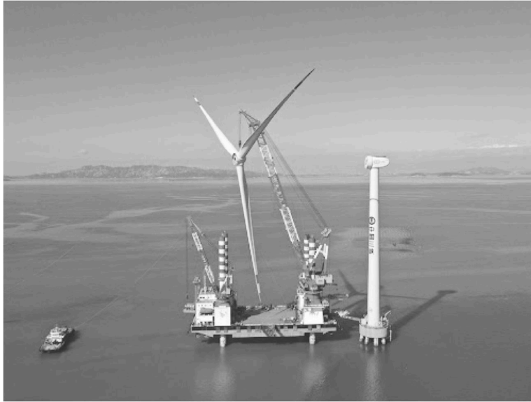
图5-30 第二种三叶式风电机组安装方式
