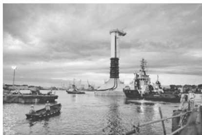
图5-21 重力式基础浮运
