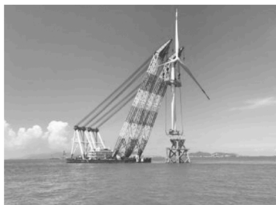
图5-18 中国交建海上风电施工技术研发中心岱山基地海上整体安装案例
