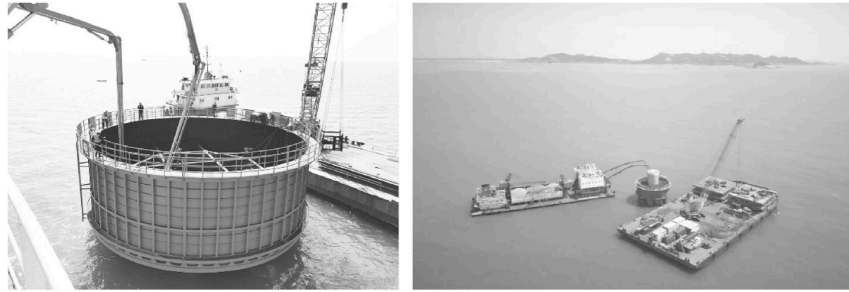
图5-16 多桩承台基础混凝土浇筑
