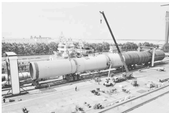
图5-3 单桩基础陆上运输
